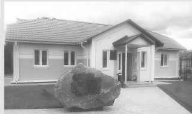
Административное здание ФСЗН после капитального ремонта.
